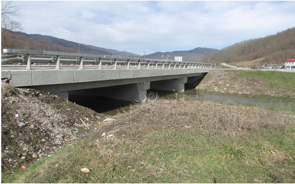
Слика 29. Мост преко Добрињске реке на км 198+247
