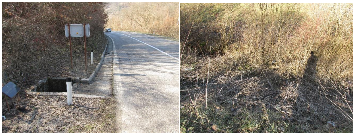
Слика 30. Уливна грађевина цевастог пропуста у риголу, десна (изливна) глава обрасла растињем
