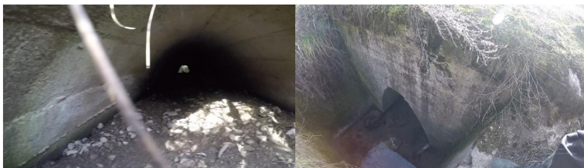
Слика 32. Засведен пропуст на км 184+881
