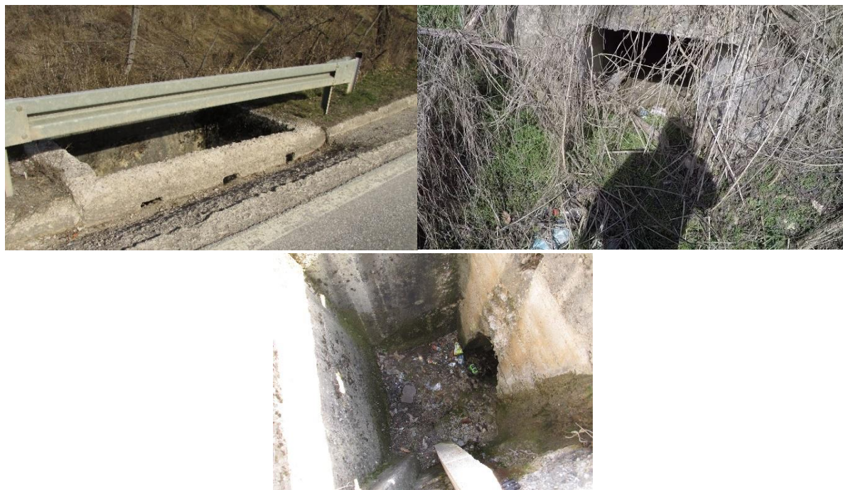
Слика 33. Комбиновани пропуст на км 185+413
