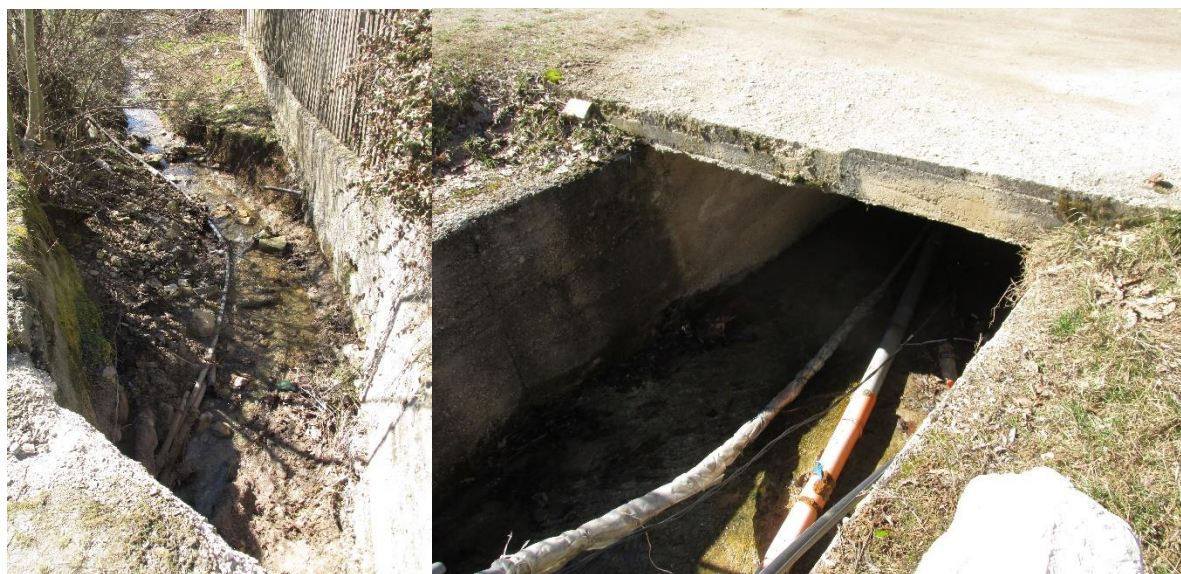
Слика 34. Плочести пропуст на км 188+750
