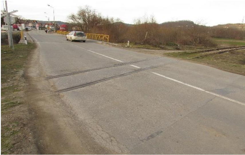
Слика 24. Индустрјски колосек на км 183+429
