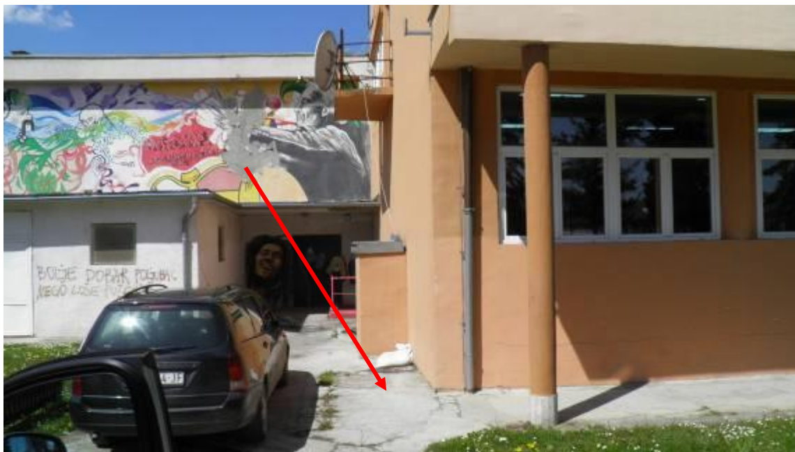
Slika 2.2.2. Pozicija kabineta radio-bazne stanice „KOSJERIĆ (DOM KULTURE)“-UEU117 UEL117.
