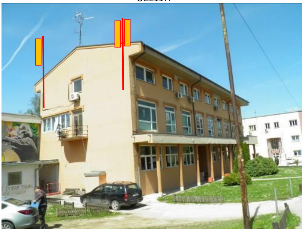
Slika 2.2.2. Pozicija nosača antena radio-bazne stanice „KOSJERIĆ (DOM KULTURE)“-UEU117 UEL117.
